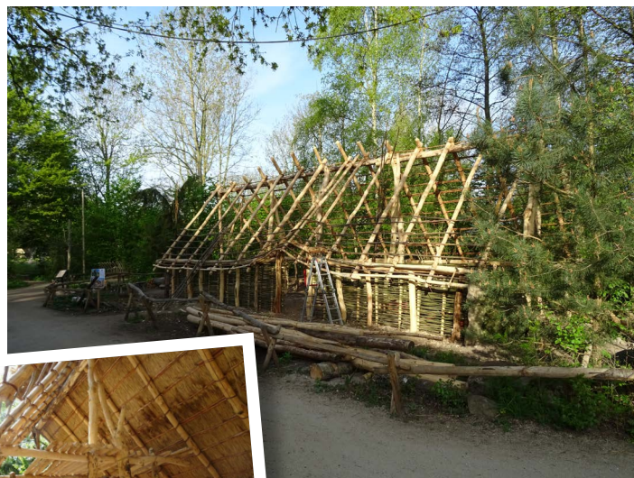
Bouw van de nieuwe
